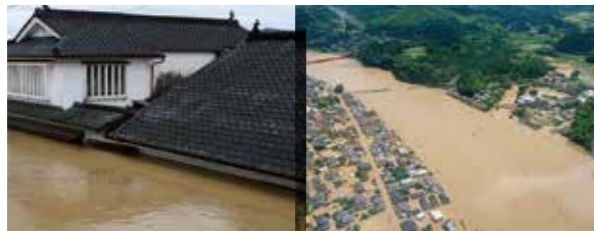
3mの濁流により一階部分が水没した大和一酒造元。
